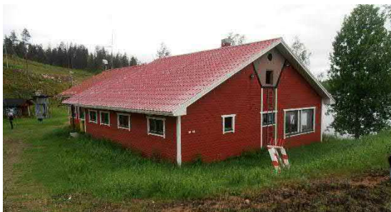
Kuva 7. Rinteiden alapuolella on laskettelukeskuksen palvelurakennus
