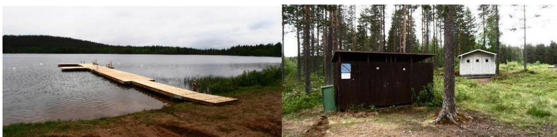
Kuva 10. Uimaranta, puulaituri, pukutilat ja käymälät
