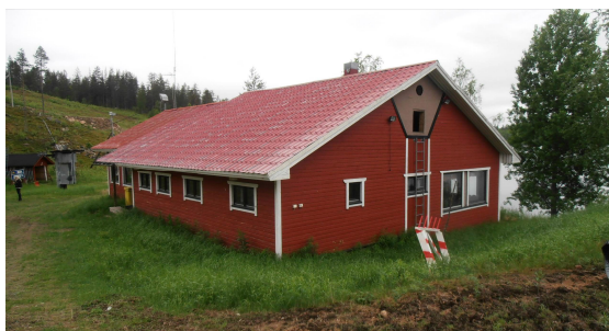
Kuva 7. Rinteiden alapuolella on laskettelukeskuksen palvelurakennus
