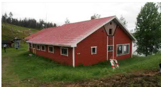
Kuva 7. Rinteiden alapuolella on laskettelukeskuksen palvelurakennus
