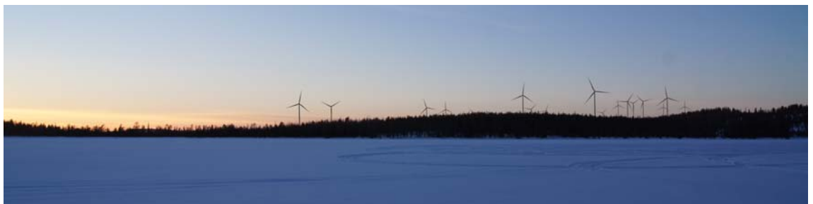
Kuva 38. Valokuvasovite Kauhajärven yli kohti tuulivoimaloita. Voimaloiden kokonaiskorkeus on 230 metriä, kameran objektiivi 18 mm. Etäisyys lähimpään Palovaaran voimalaan 2,5 km.
